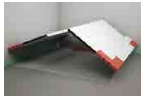
6. Posle uklanjanja belog oplatnog elementa, nakon što se cementna košuljica osušila, pad na ploči je izrađen sa 3% prema zidu.
