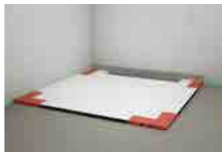
5. Završna visina cementne košuljice i markirana visina tuš-ploče izjednačena je oko celog elementa.
