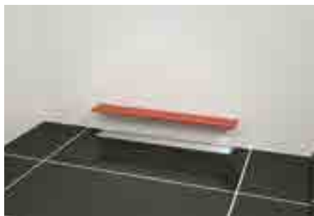
8. Postaviti pločice, fuge ispuniti i privremenu građevinsku zaštitu otkloniti.
