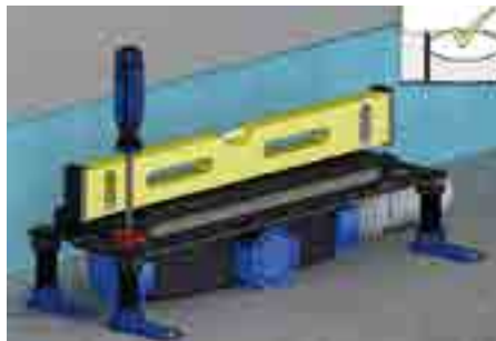
2. Podesiti visinu tela slivnika, i sa svih strana vodoravno postaviti.
