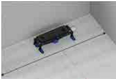
1. Odrediti mesto ugradnje tela slivnika, i na konstrukciju pričvrstiti.
